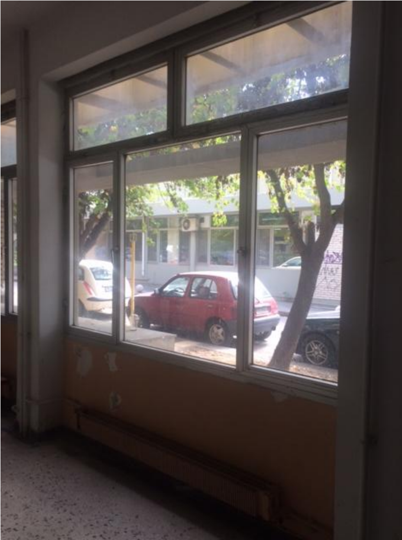
Εικόνα 1: Υαλοστάσια αλουμινίου μεμονωμένα δίδυλλα, ανοιγόμενα / ανακλινόμενα περί κατακόρυφο ή οριζόντιο άξονα, με σταθερό φεγγίτη και σταθερό τμήμα
